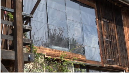
Fig.34 : Chauffe-eau solaire en low-tech, ©Low-Tech Lab, S.D.
