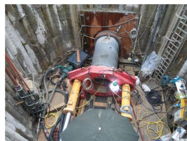
**FIGURE 6.1** – Collecteur d'égout en cours d'installation. (Source : *inBW*.)
