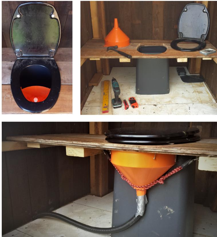
FIGURE A.6 – Siège de toilette avec son séparateur d’urine et le conduit pour les fèces
