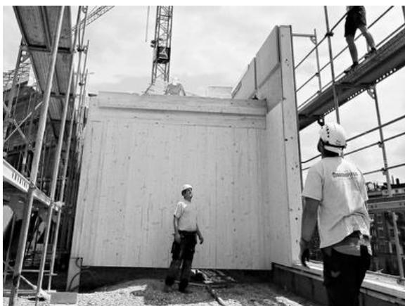
Fig.59 : Assemblage de la façade sur site
