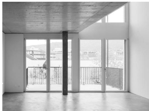
Fig.58 : Structure béton indépendante de la façade
