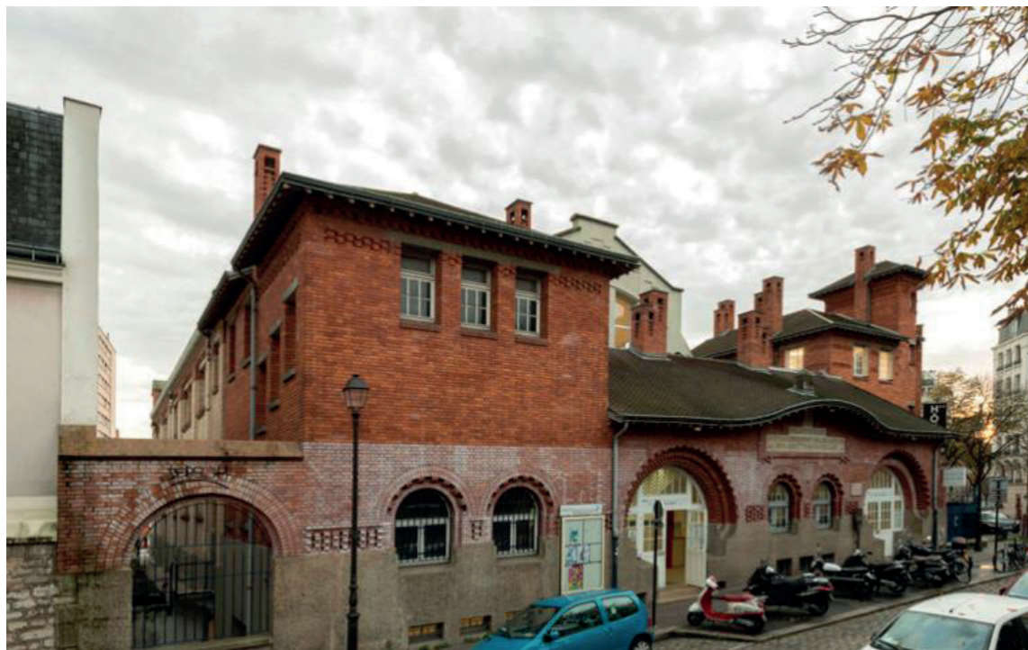
(1) Vue depuis la façade d'entrée des bains publics © TNA architectes, Gallica BNF
