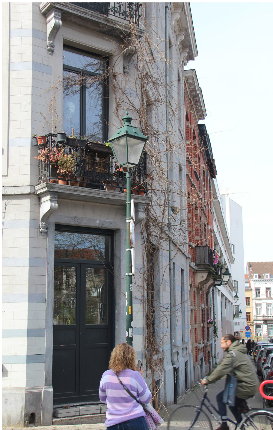
Fig 46 : Rez-de-chaussée anciennement commercial. Rue de la Rhetorique. Gabriel. 2025
