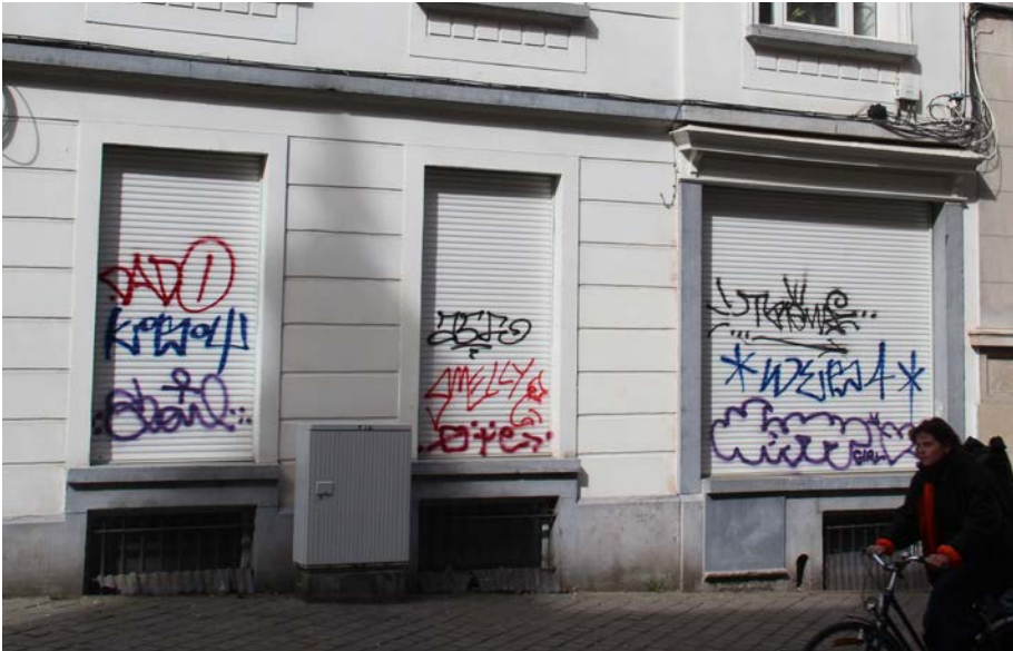
Fig 45 : Rez-de-chaussée anciennement commercial. Rue du lycée. Gabriel. 2025
