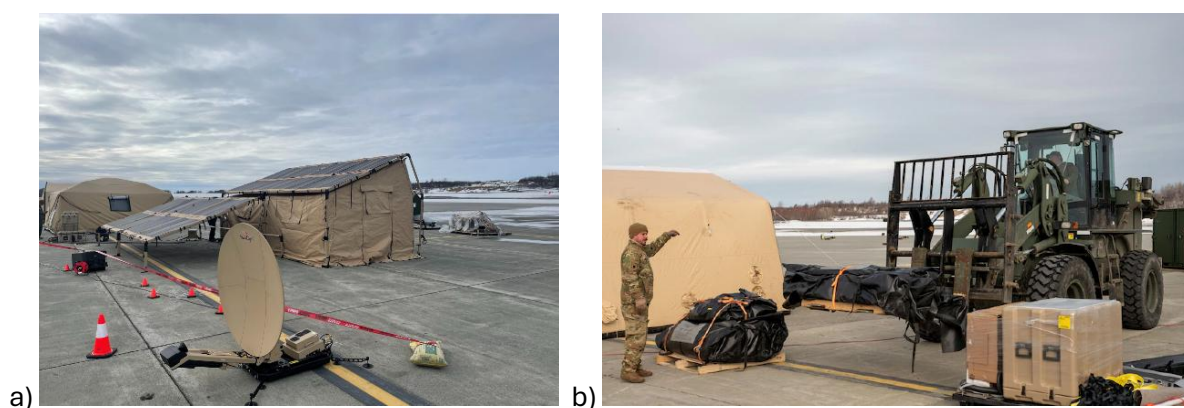
Figure 93 : Structure solaire déployable SPIS (Solar Powered Integrated Structure) de l'entreprise Pvilion a) installation sur site ; b) transport logistique.
