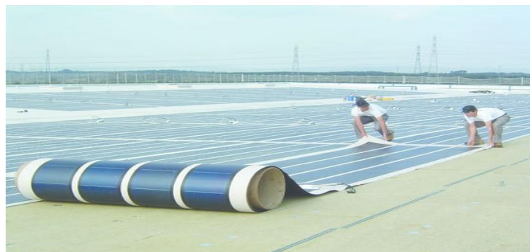
Figure 75: Déploiement d'un rouleau d'une membrane d'étanchéité produisant de l'électricité solaire
