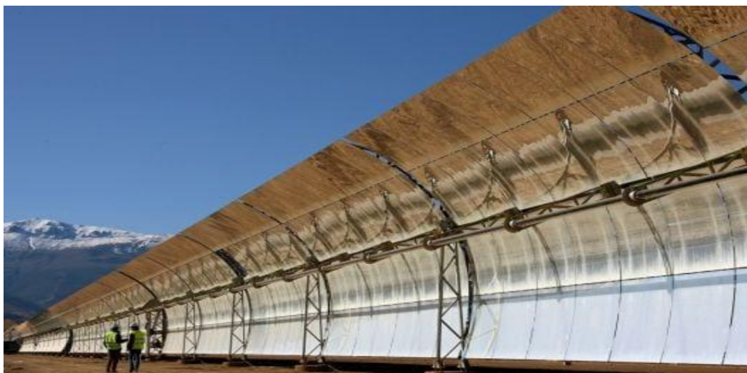
Figure 7 : Andasol, une des plus puissantes centrales thermodynamiques d'Europe située en Espagne
