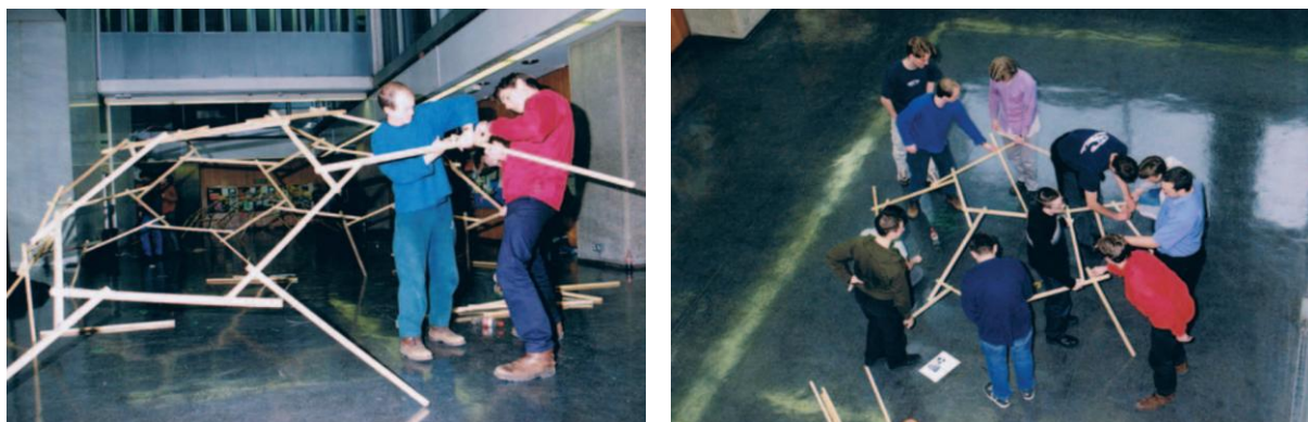
Figure 48 : Mise en œuvre manuelle d'une structure à barres fixes double nappe.
