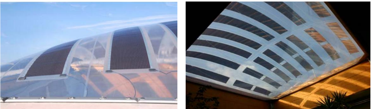
Figure 85 : Système pv flexible associant des cellules photovoltaïques à des membranes translucides en PTFE et transparentes en ETFE dans le cadre d'un prototype intégré à un bâtiment. ; a) Vue extérieure. ; b) Vue intérieure.
