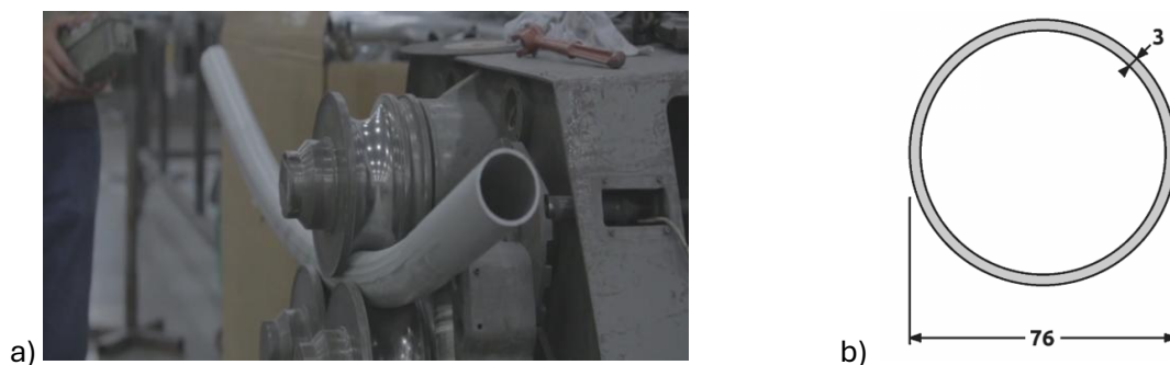
Figure 120 : a) Cintrage de tube rond aluminium pour la structure du pavillon Pure Tension b) Coupe transversale du tube rond en aluminium 6060 T6, Ø76 mm, épaisseur 3 mm, utilisé pour la structure de l'esquisse.
