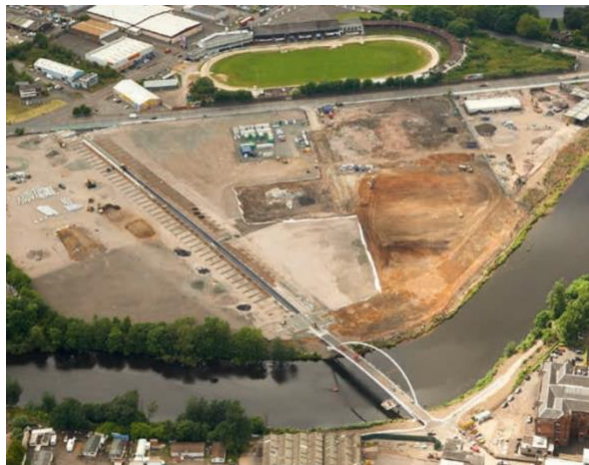
Vue aérienne d'une partie du site Shawfield (Glasgow), 2014 (© VHE)
