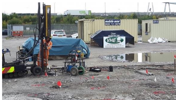
Installation du dispositif d'injection de CaS à Shawfield (Glasgow), 2019 (© VHE)
