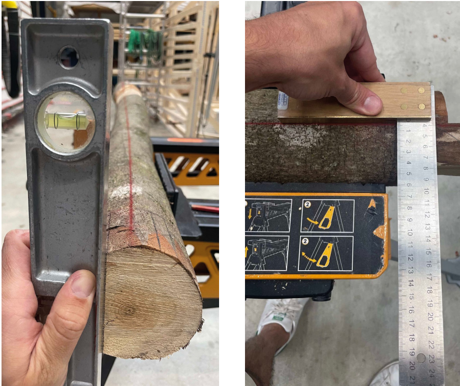
Fig.34- Tracé du tenon, Septembre 2024
