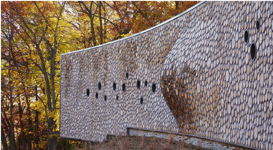
Fig40- Rendu de matérialité d'un mur maçonné en bois cordé - Arcus Center for Social Justice Leadership / Studio Gang
