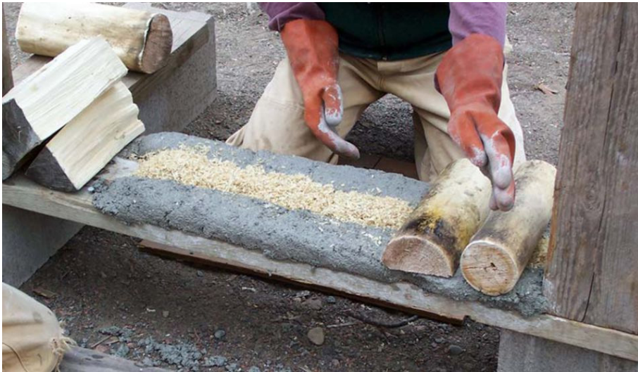
Fig.41- Mise en œuvre d'un mur en bois cordé
