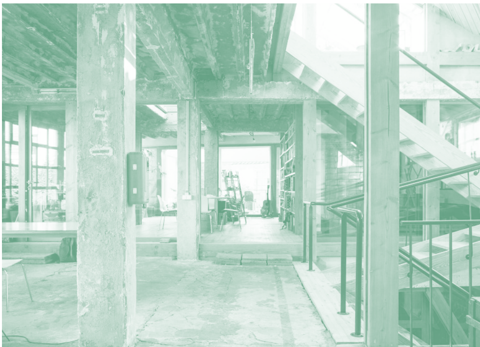
fig. 68 : Vue intérieure (niv. +1)
