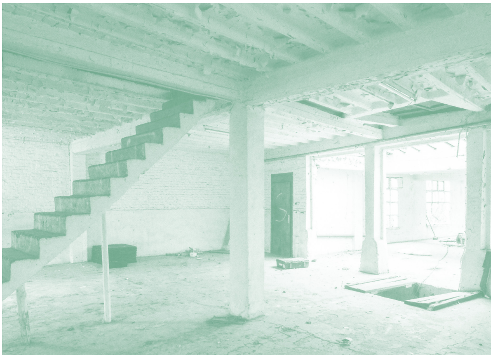
fig. 56 : Vue intérieure du site existant
