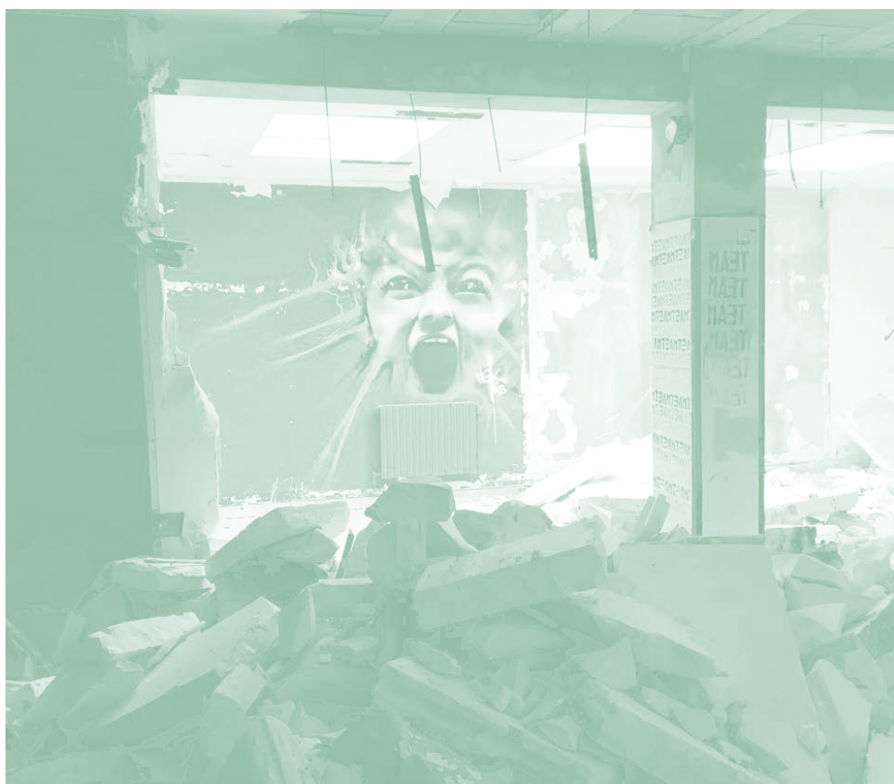
fig. 76 : Vue intérieure de l'existant
