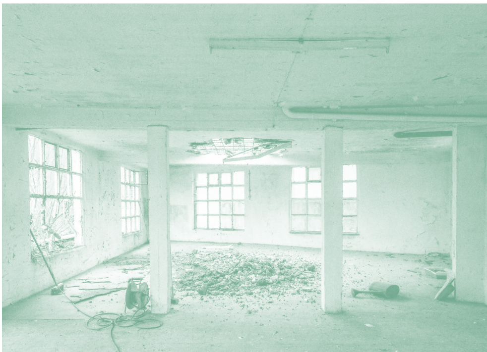
fig. 57 : Vue intérieure du site existant
