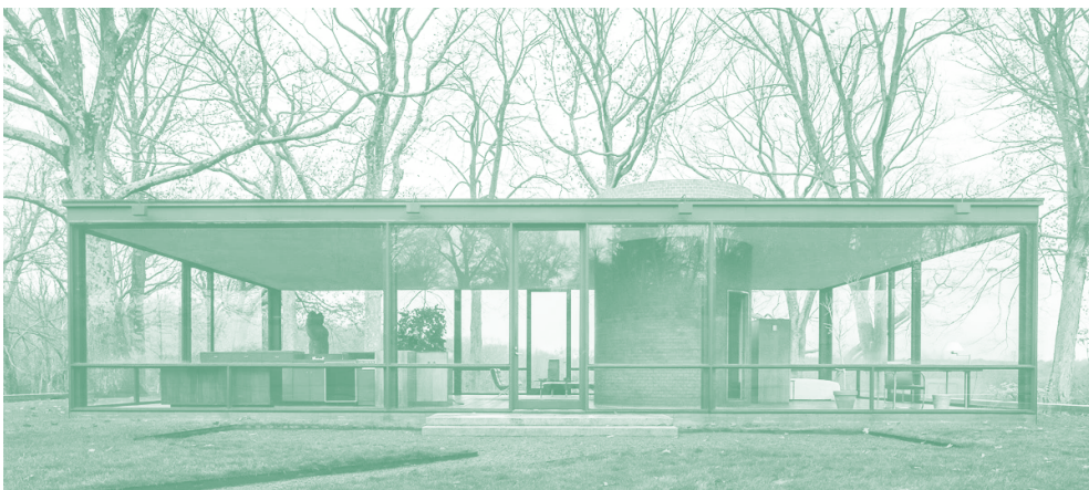
fig. 16 : Glass house de Philippe Johnson
