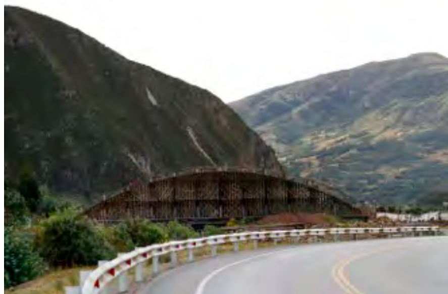
11-4, pont en construction, sens Urcos
