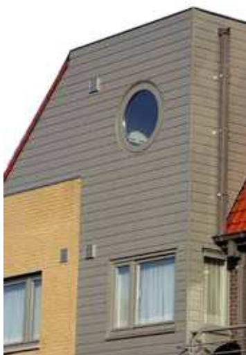
Figure 26 : Photographie bardage en PVC
