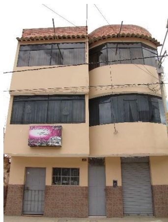
Figure 220 : Façade de l'immeuble.
