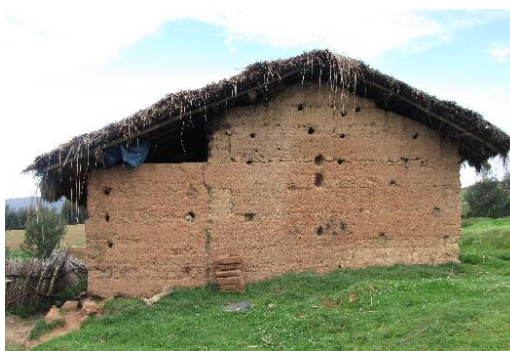
Figure 84 : Pignon de la maison montrant l'importance des trous dont le diamètre s'est élargi au fur et à mesure des années.
