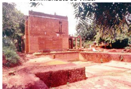
Figure 321 : Carrière de terre intégrée en sous sol du 3 ème bâtiment.
