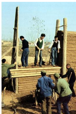
Figure 72 : Technique du pisé en Chine
