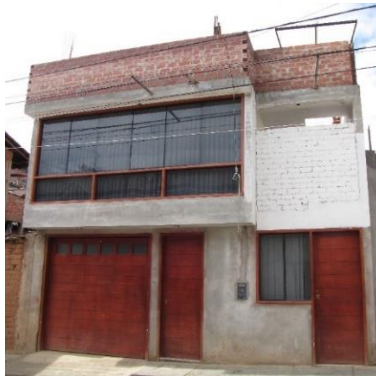
Figure 59 : Importance des baies permises par le principe de la façade libre grâce au système à base de poteaux-poutres.
