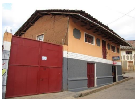
Figure 262 : Bloc en pisé
