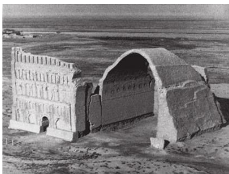
Figure 152 : Arche de Ctésiphon en Irak
