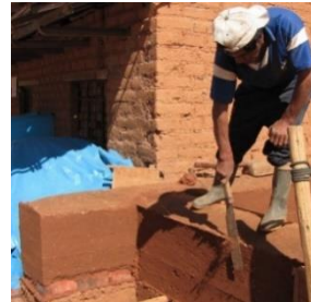
Figure 74 : Quelques étapes de la construction d'une maison en pisé.
