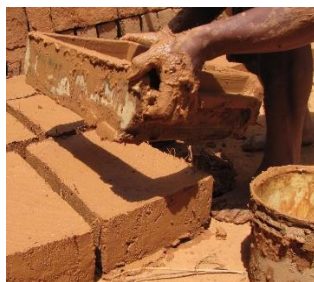
Figure 161 : Etapes de fabrication d'une brique d'adobe.
