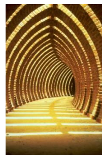
Figure 313 : Couloir de l'hôpital Kaédi
