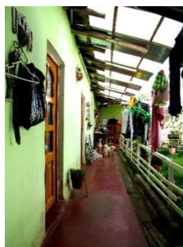
Figure 113 : Galerie du second patio
