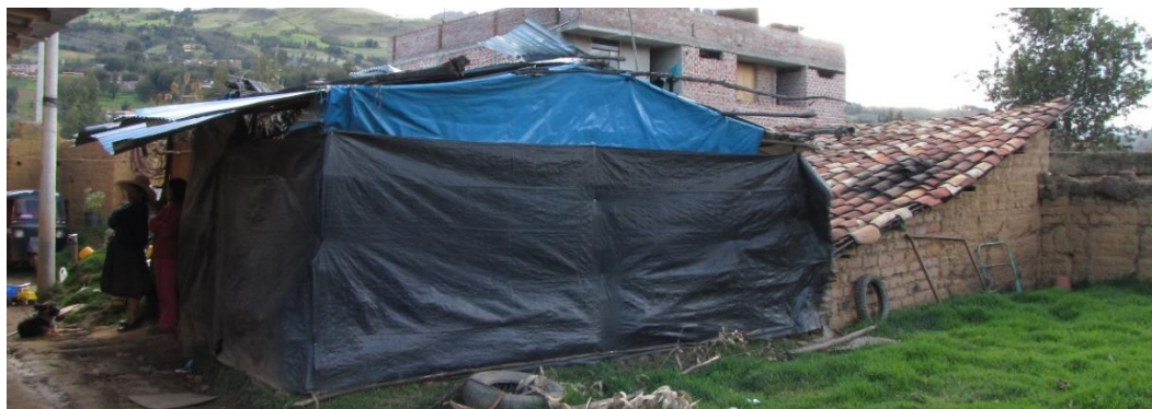
Figure 176 : Vue d'ensemble de la maison 5.
