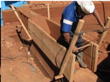
Figure 74 : Quelques étapes de la construction d'une maison en pisé.
