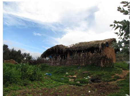
Figure 77 : façade avant de la maison 1 étudiée.
