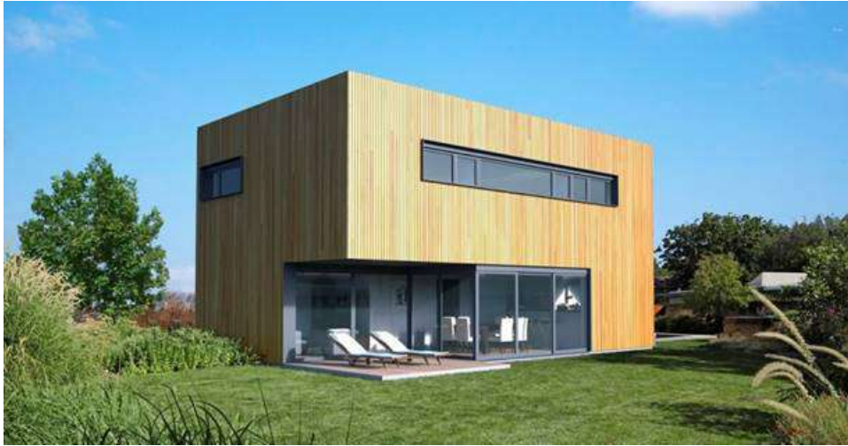
FIGURE 4.25 – Maison NCube à Aubange
