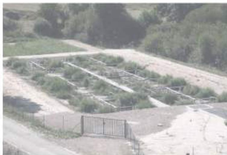
*Exemple d'installation d'un filtre à roseaux plantés sur sable de l'entreprise Aistep, constructeur de matériels pour stations de production d'eau potable et de traitement des eaux usées et pour les eaux pluviales.<sup>57</sup>*
