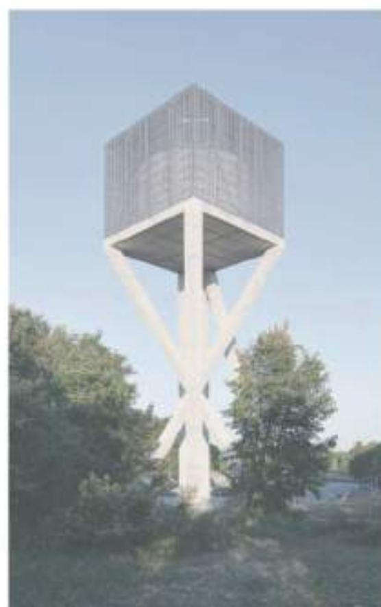
*Une boîte transparente sur une structure en béton armé.<sup>89</sup>*
