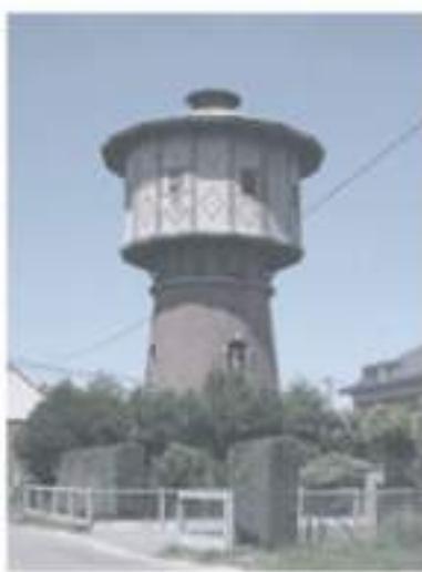
Château d'eau avec une cuve en acier entourée d'un bardage en briques vernissées<sup>66</sup>
